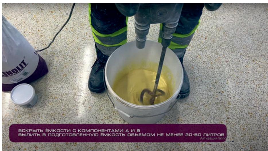
2. Постепенно внести наполнитель (компонент С) в смесь, мешать в течение минимум 2 минут до полного перемешивания и получения гомогенной (однородной) смеси. Рекомендуемое время смещивания 2-3 минуты. Особое внимание следует уделять тщательному перемешиванию материала в зоне дна и стенок ведра во избежании дефектов покрытия (плохо перемешанные компоненты и комки сухой смеси не полностью вступают в химическую реакцию).
